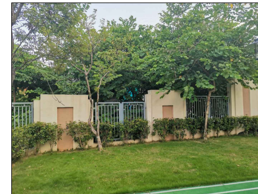
C、D段围墙实景图
