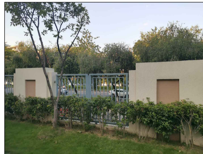
A、B段围墙实景图
